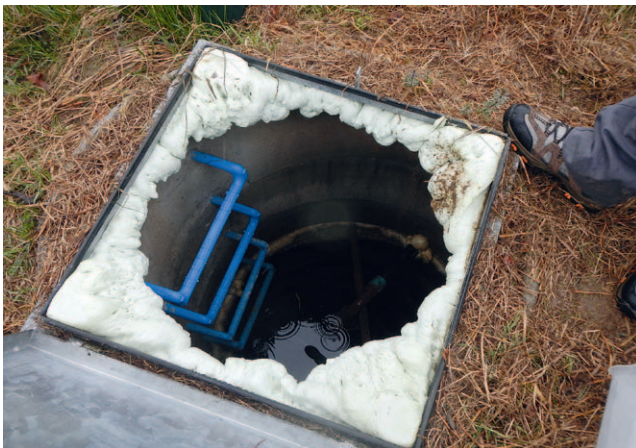
Mangelhaft abgedichteter Quellschacht (links) und Bohrbrunnen (rechts)
