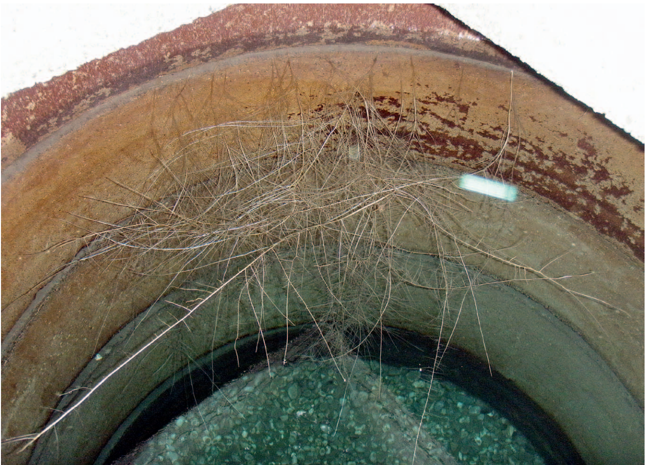
Baumwurzeln wachsen in die Quellfassung
