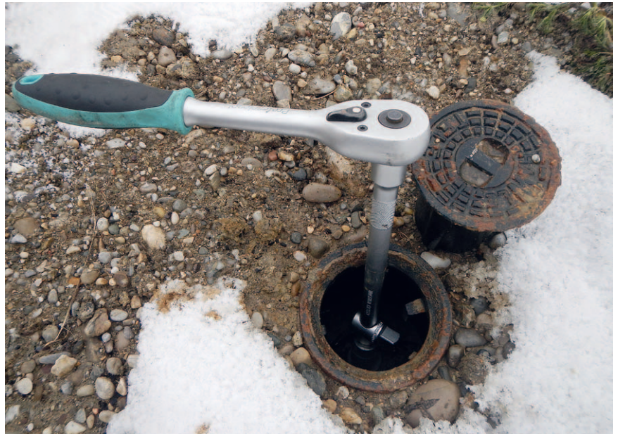
Absperrschieber einmal pro Jahr öffnen und schließen
